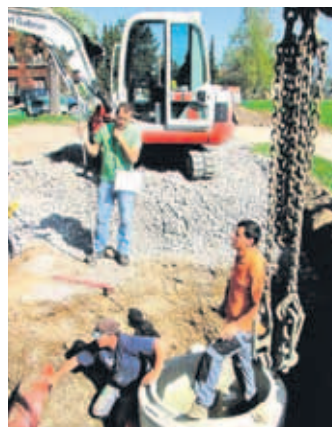
Laufen auf Hochtouren: Bauarbeiten in Amerlügen. FOTO: KOE
