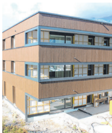
Die Arbeiten an der Wohnanlage Krüzbühel liegen gut im Zeitplan. VN/JS
