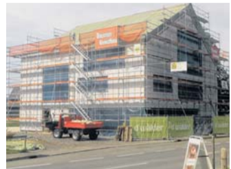
Ein markanter Bau entsteht derzeit im Ortszentrum von Andelsbuch.
