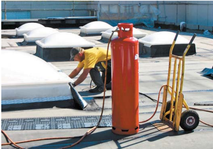
Derzeit sind die Arbeiten am Schuldach im Gang. FOTO: VN/J. SCHWALD
