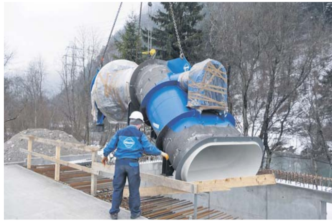
Die Turbine (im Bild) und der Generator fürs Kleinwasserkraftwerk Brunnenfeld wurden in den vergangenen Wochen eingebaut. FOTO: VIW
