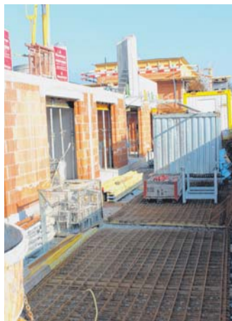
Derzeit entsteht der Rohbau der Wohnanlage in Nenzing.
