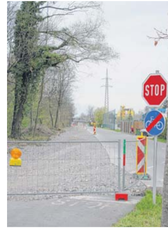
Der Untergrund des neuen Radwegs in Nüziders wird vorbereitet.
