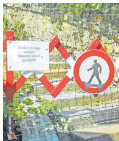
Die Sanierung der Meißnerstiege in Bregenz steht vor der Fertigstellung.
