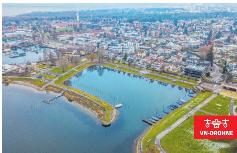
Das Binnenbecken soll frei von Passagierschiffen bleiben.
