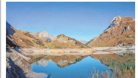
Auch in Zukunft wird hier die Grundlage für ÖBB-Strom gespeichert werden. ÖBB/KAPFERER
